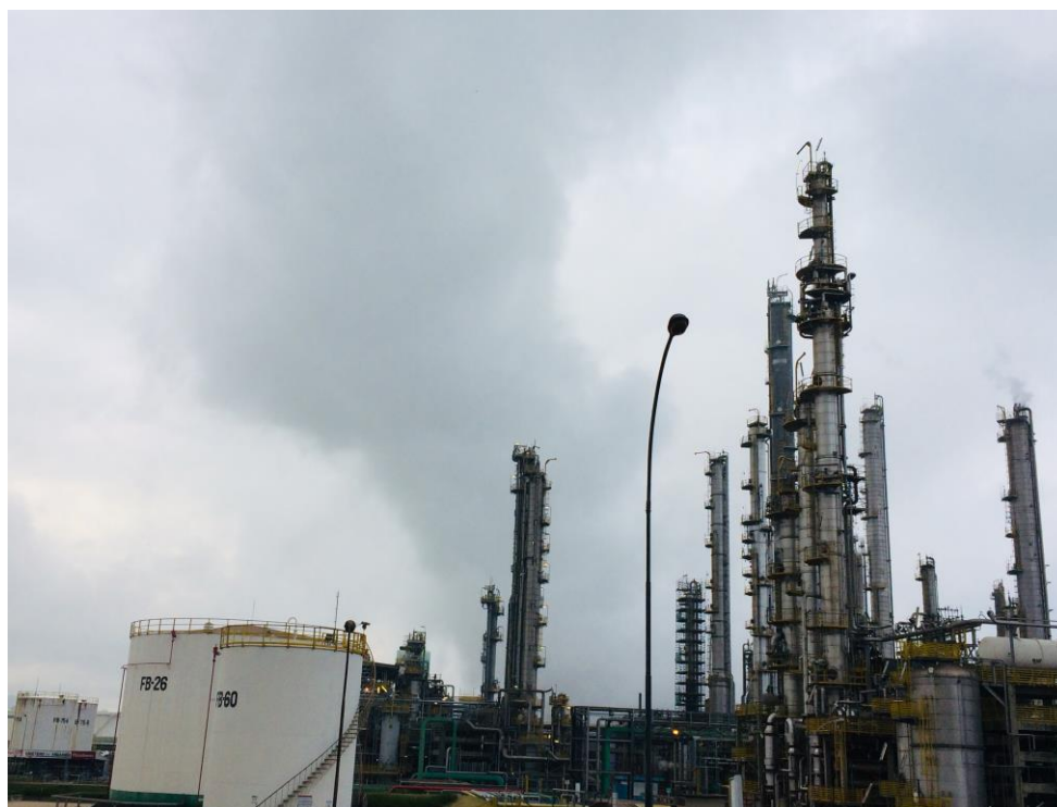
Figura 36 – Vista parcial de uma planta petroquímica
